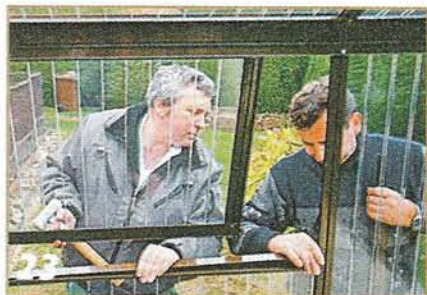
23 Окно продольной стены вставляют в направляющий паз водосточного жёлоба. Под окно монтируют опору.
