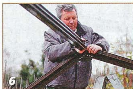
6 Элементы фронтона соединяют болтами с коньковым прогоном.
