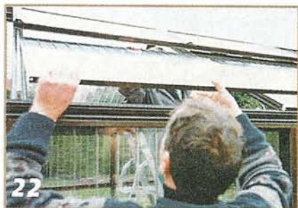
22 Монтаж окна крыши. Вставив оконную раму в направляющий паз конькового прогона, её устанавливают в требуемое положение.
