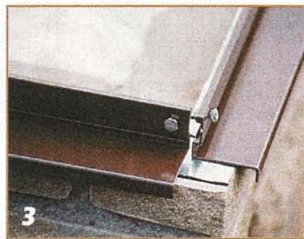
3 Сначала на цоколь кладут элементы металлической рамы теплицы, соединяя их друг с другом болтами.
