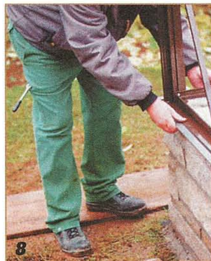
8 Угловой подкос крепят к цокольному элементу. Для этого в первое отверстие цокольного элемента вставляют и затягивают болт с шестигранной головкой.
