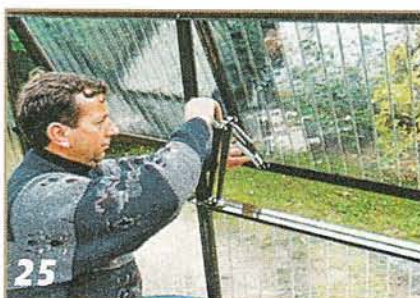
25 Внизу элемент снабжают торцовым завершающим профилем, вверху монтируют автоматический открыватель окна продольной стены.
