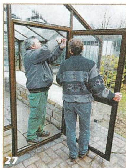
27 Заранее остеклённую дверь устанавливают в дверной проём.
