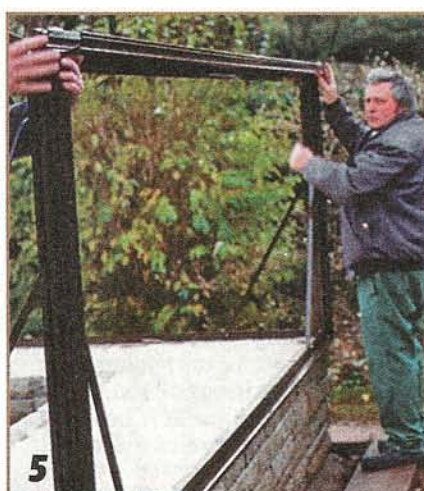
5 Закрепив угловые подкосы, устанавливают профиль водосточного жёлоба как верхнего завершающего элемента продольной стены.
