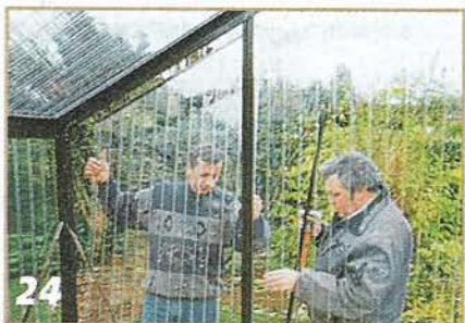
24 Прежде чем установить элемент остекления в продольной стене, его обрамляют дистанционными профилями. Верхний завершающий профиль поставляется как погонажное изделие.
