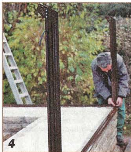
4 Угловые стойки временно фиксируют до момента установки подкосов.
