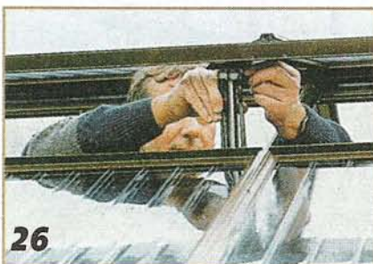
26 Работу открывателя следует проверить в течение нескольких дней. При необходимости его можно подрегулировать.
