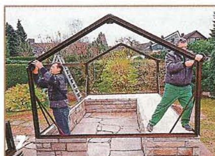
9 Собранные фронтонные элементы прикрепляют на болтах с угловыми стойками. При наличии помощников фронтоны и коньковый прогон можно собрать на земле и в собранном виде установить на угловые стойки.
