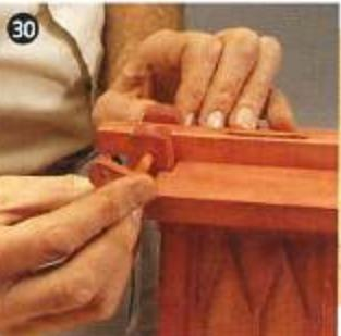
**30.** Ложную гайку запора необходимо прикрепить к консоли. Вставьте запор, нанесите тонкий слой клея на гайку и продените ее вдоль запора так, чтобы она была прижата к консоли. Просверлите небольшое отверстие (2 мм) сквозь запор и с помощью молотка вбейте в него штифттик, который должен войти в консоль. Выньте запор, сотрите следы клея и дайте ему просохнуть.
