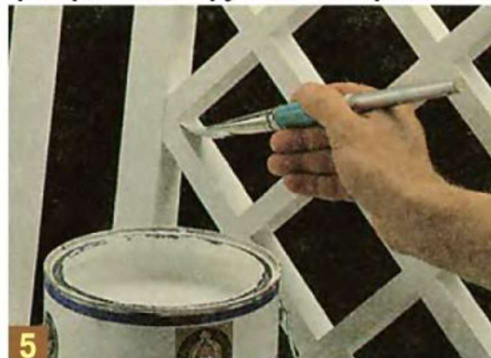
5 Прибив решётку на место, отверстия от шляпок гвоздей я зашпаклевал и закрасил.
